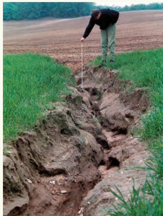
Abb. 59: Beispiel „Onsite-Schäden“ auf dem Acker: Erosionsgraben infolge von starkem Niederschlag (Quelle: Geologischer Dienst NRW)
